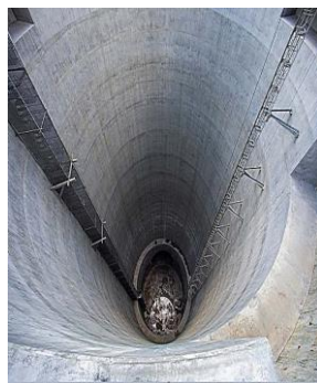
東百合ヶ丘非常口 深さ94メートル 大きさは直径39m
