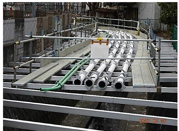
外環道トンネル工事で地盤が緩んだ。地盤改良材を地中に注入する配管を入間川の上に設置している
