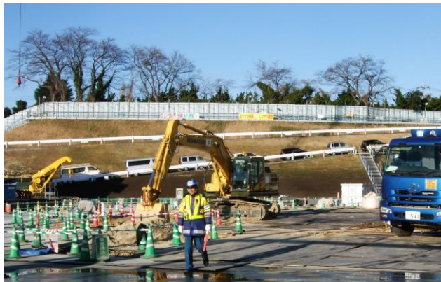
(東百合丘非常口工事現場)
