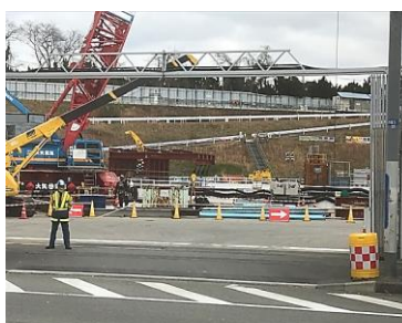
東百合丘非常口工事
