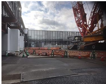
梶ヶ谷非常口工事
