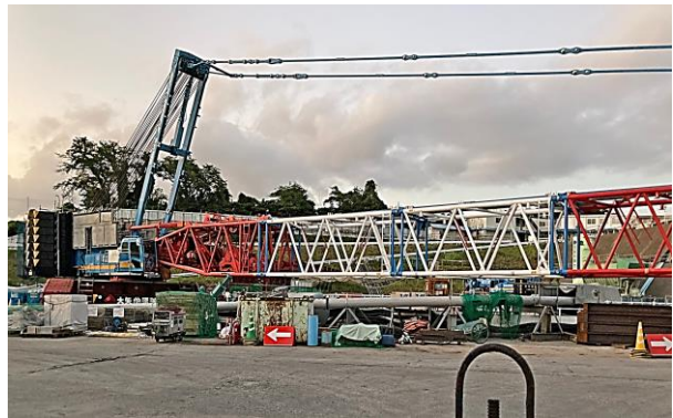
川崎市麻生区東百合ヶ丘非常口近影（8月） （撮影：二宮敬嗣）
