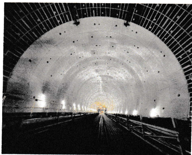
○東百合ヶ丘工区の坑内の状況（2023年9月29日撮影）
