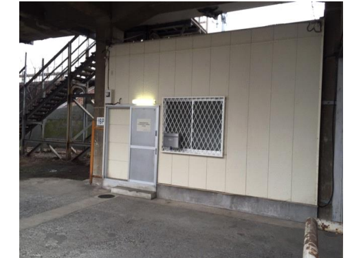
JR東海が中原区に設置し、工事事務所と称する、横須賀線ガード下のプレハブ小屋
