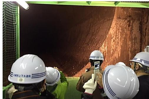
ゴンドラで55m降りた雨水貯留管トンネル
