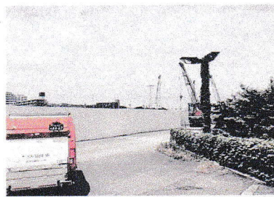
宮前区 梶ヶ谷非常口工事現場
