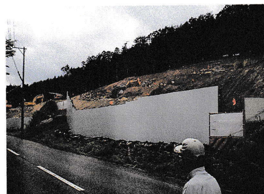
瀬戸トンネル工事現場
