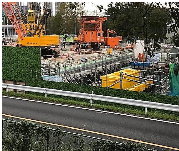
多摩川の堤防から見た等々力非常口工事現場
