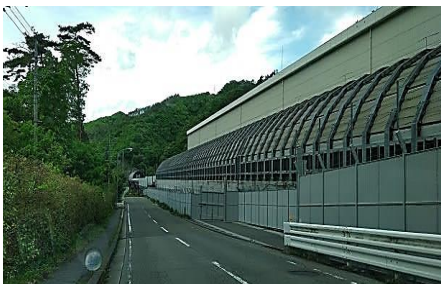
2019.10.7 山梨実験線車両火災
