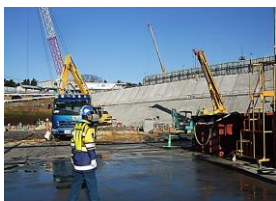
東百合ヶ丘非常口工事
