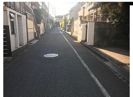
調布市の陥没現場周辺
