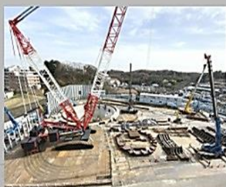
シールドマシン 組立の準備工
