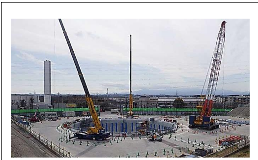
東百合ヶ丘非常口 (工事中写真) JR東海
