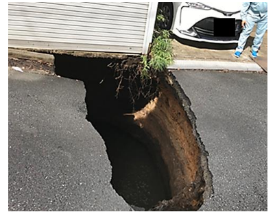
(2020年10月調布市の陥没事故)
