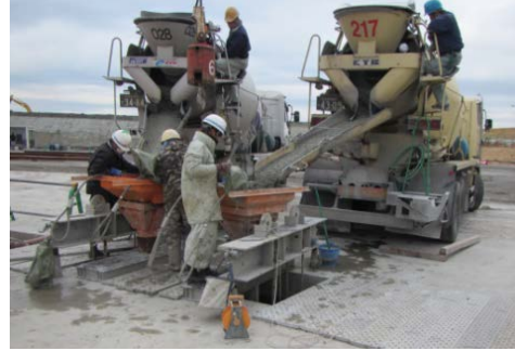
図 2-4(5) 土留壁工の施工手順（写真は類似工事の例）
