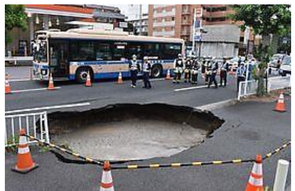
(横浜港北区の陥没事故現場)
