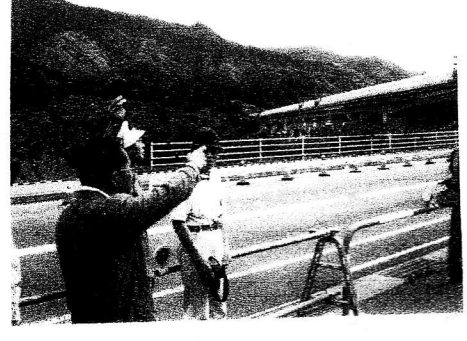
(実験線延伸工事)
