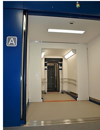
電磁波シールドされた リニア山梨実験線駅の乗車通路
