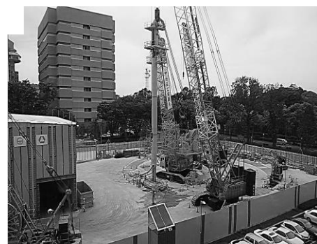
(名城非常口工事)
