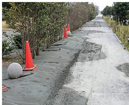
東日本大震災で液状化した東扇島 (写真：横浜地方気象台)
